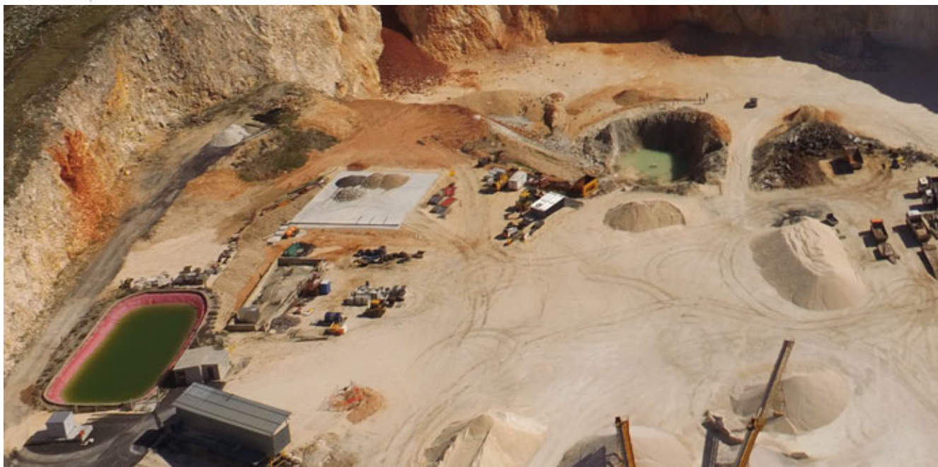
Fotografia aerea del fosso di guardia e delle cisterne, scattata il 15 Marzo 2019 con Drone DJI Phantom 3PRO
